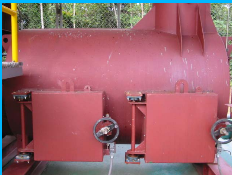
Foto No. 9 Cámara terciaria de asentamiento de cenizas
